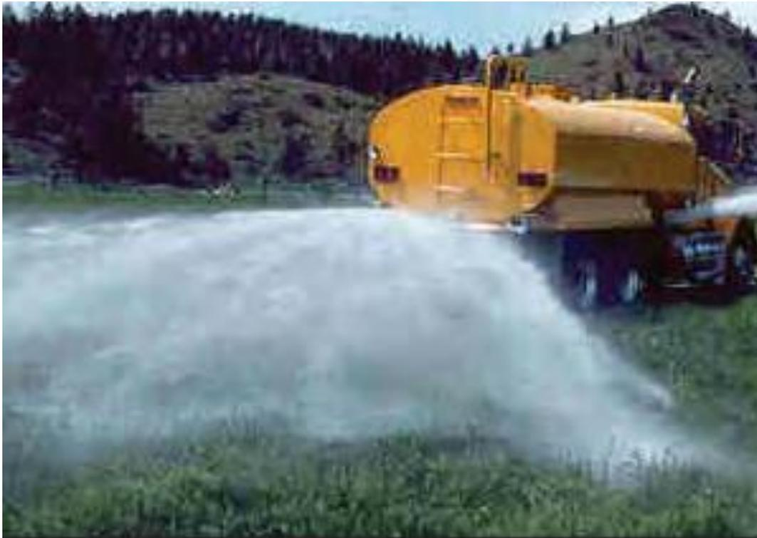
**Figure 21 : Arrosage du sol visant à réduire la dispersion des fibres d'amiante sur chantier**
