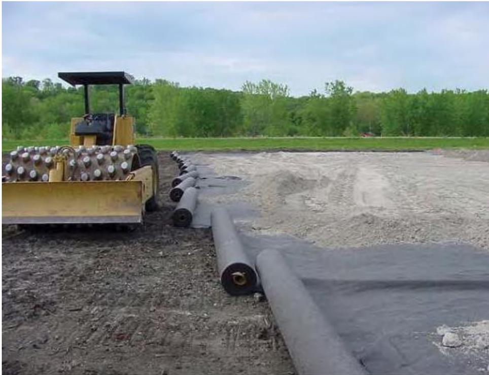
**Figure 20 : Géotextile visant à informer de la présence d'amiante**
