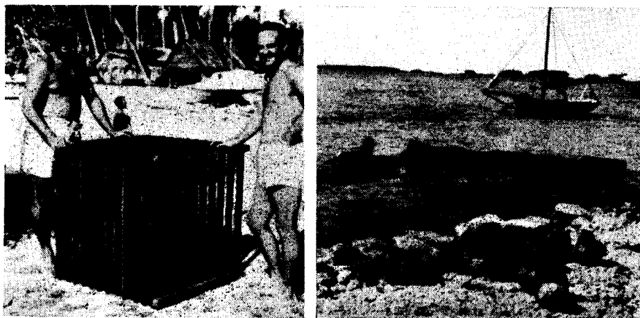
Ci-dessus: un des nouveaux collecteurs à naissain fabriqué d'après les plans de M. Hynd. Chaque collecteur comprend 12 cadres standard de 0m, 90 au carré, en bois recouvert de grillage enduit d'un mélange de sable, de ciment et de "flintkote". A droite: collecteurs tombant en ruine.
