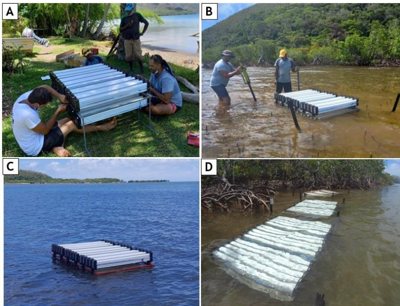
Image 3 : Montage des collecteurs sur la table (A) et installation des tables sur les sites de Port Bouquet (B), Baie du Vieux Touho (C) et Prony (D)
