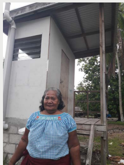
L'une des installations établies grâce au projet KIRIWATSAN aux îles Gilbert.
