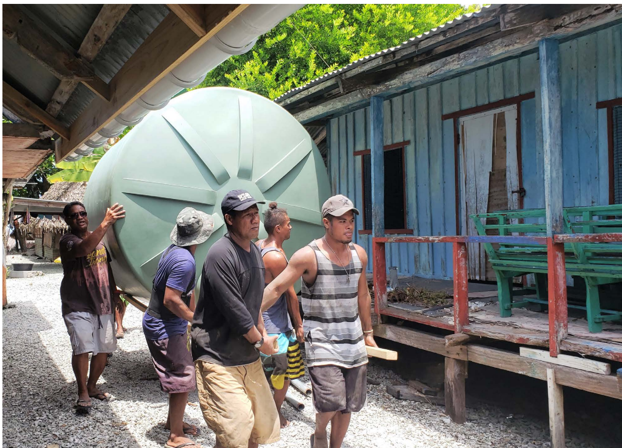
Mise en application des enseignements tirés : des habitants participent aux travaux d'installation de nouveaux systèmes d'adduction d'eau à Kapingamarangi, dans l'État de Pohnpei (États fédérés de Micronésie).
