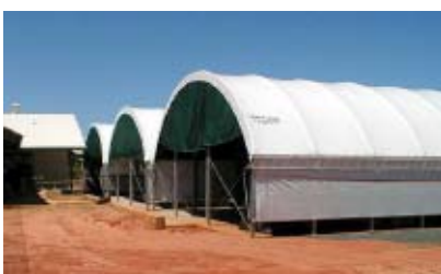
Les trois tunnels de l'écloserie. Chaque tunnel recouvre une superficie de 400 m2
