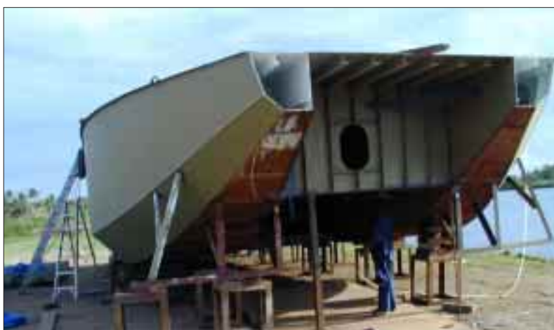
Figure 3 (en haut) : L'enrouleur de Seamech Figure 4 (au milieu) : Ros et Shane Brodie, de Seamech Hydraulics, démontrent un nouveau système de palangre à enrouleur Smart Reel Figure 5 (en bas) : Une des barges construites par Bluewater Craft
