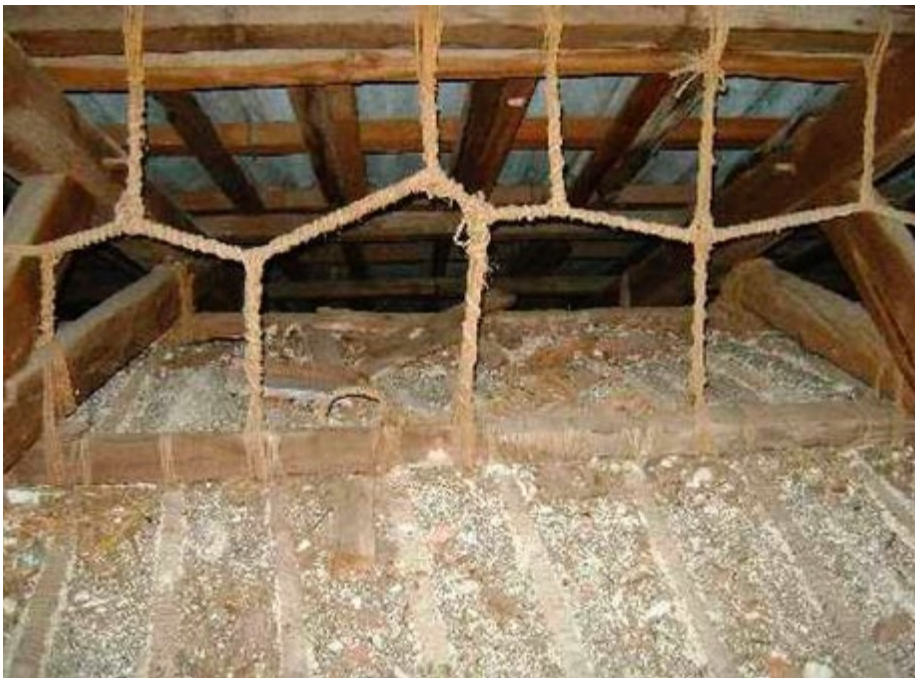
Figure 18 : Exemple de cordage mis en place dans la charpente de la Cathédrale de Rikitea
