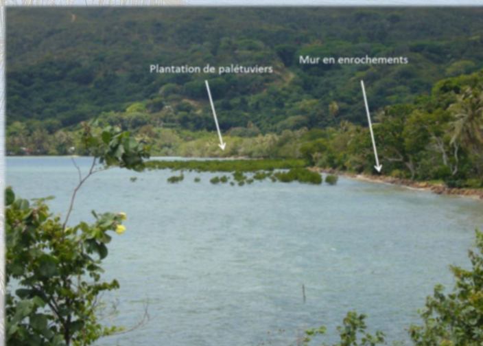
Stratégie mixte de protection contre l'érosion : barrière végétale et mur en enrochement (Pt222, Pwatètè Mission, Touho) (extrait de OBLIC, 2014)
