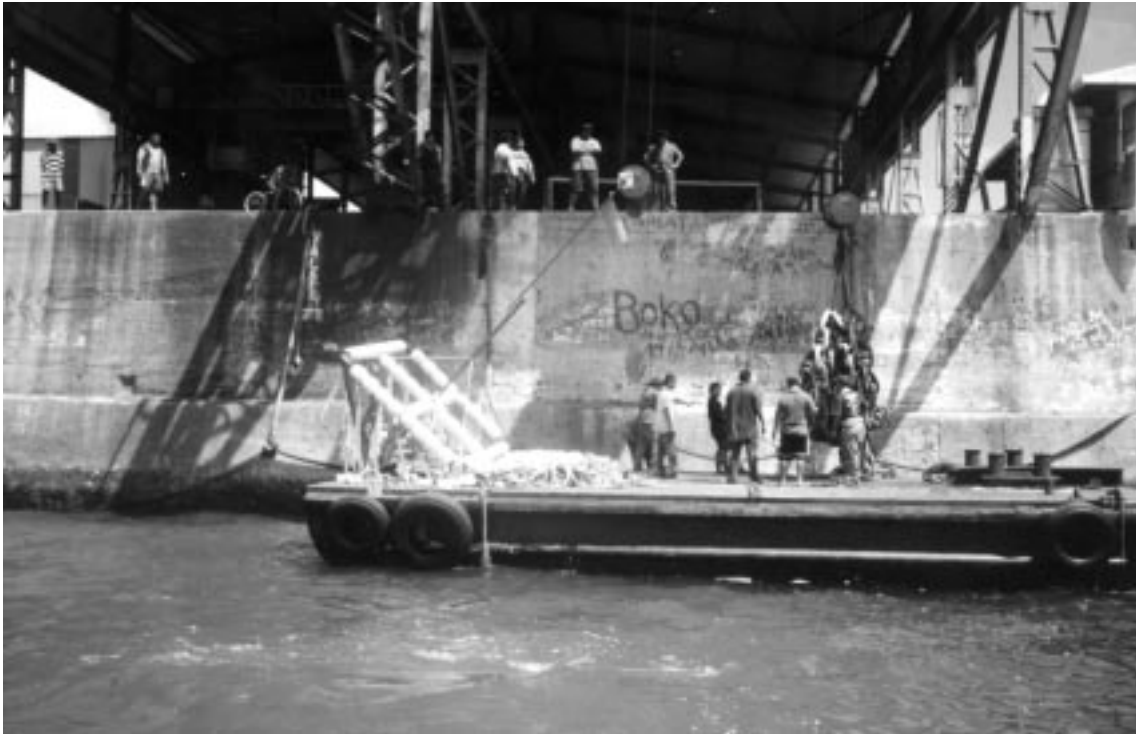
Figure 1 : Chargement à bord de la barge du matériel pour la pose du DCP
