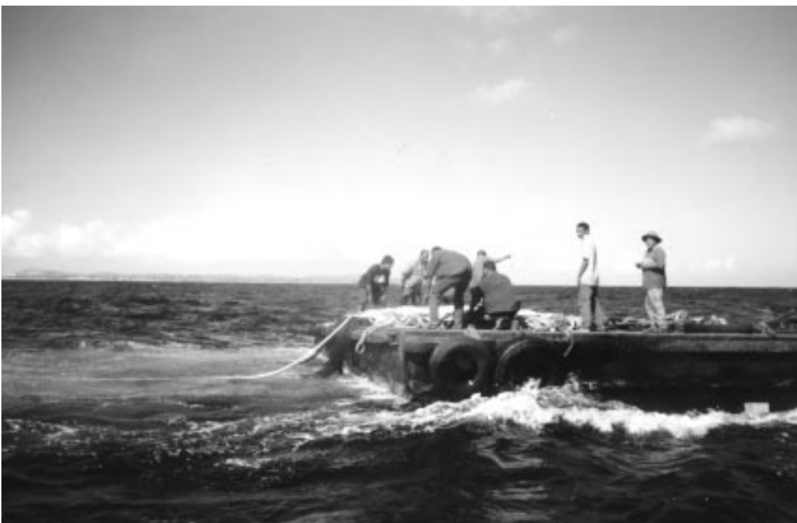
Figure 2 : Mise à l'eau de la ligne de mouillage du DCP sur le site retenu
