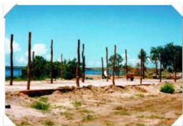
L'écloserie de One Arm Point au début de la construction Notez l'utilisation de bois local pour la construction.
