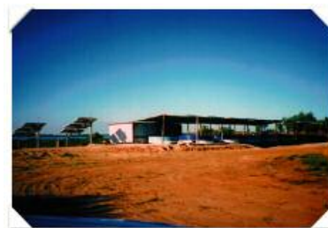
Vue de l'écloserie à la fin des travaux. Note: l'énergie est fournie par les panneaux solaires, sur la gauche.
