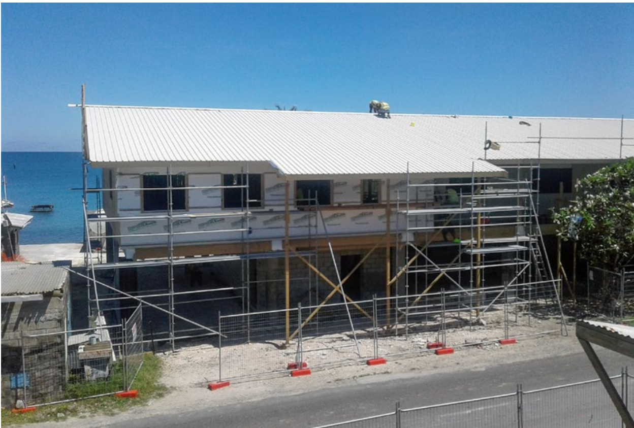
Les nouveaux locaux du service des pêches de Tuvalu devraient être achevés en octobre 2017 (crédit photo : Garry Preston).
