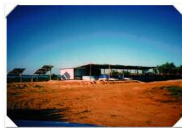
Vue de l'écloserie à la fin des travaux. Note: l'énergie est fournie par les panneaux solaires, sur la gauche.
