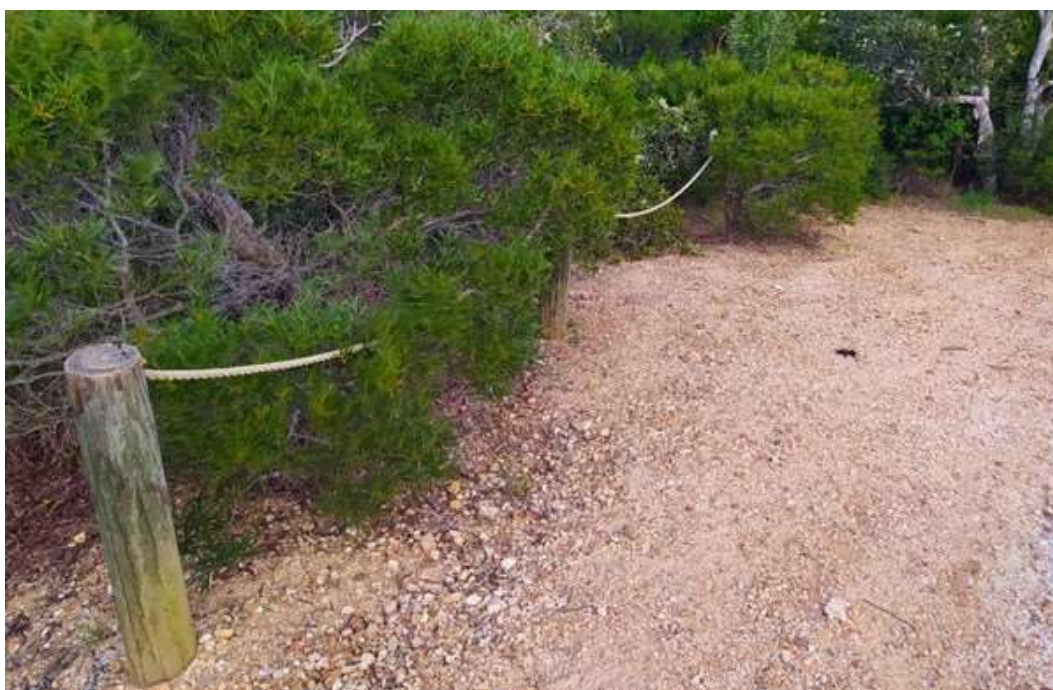
Photo 15. Barrière mixte poteau-corde de sentiers de randonnées, pin des caraïbes traité CCA, Nouméa
