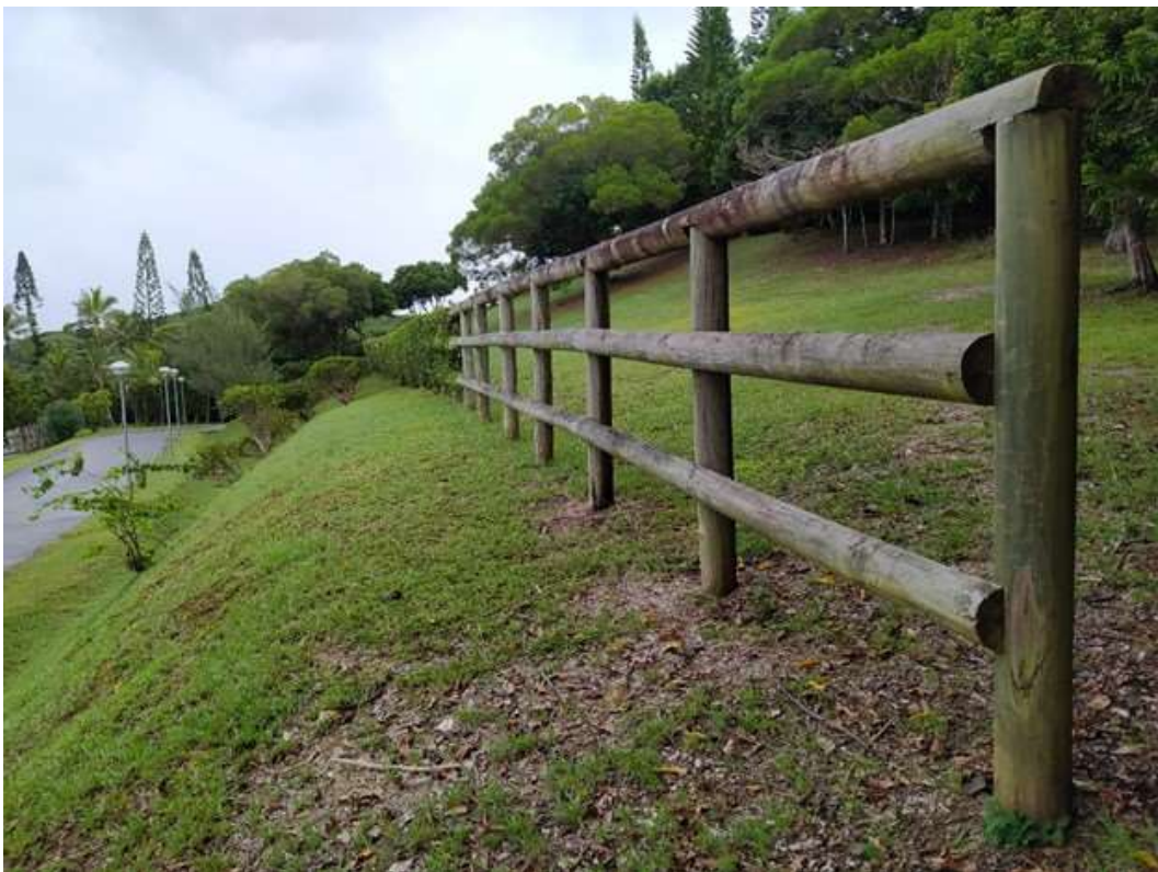
Photo 10. Barrière de séparation, pin*, Nouméa
