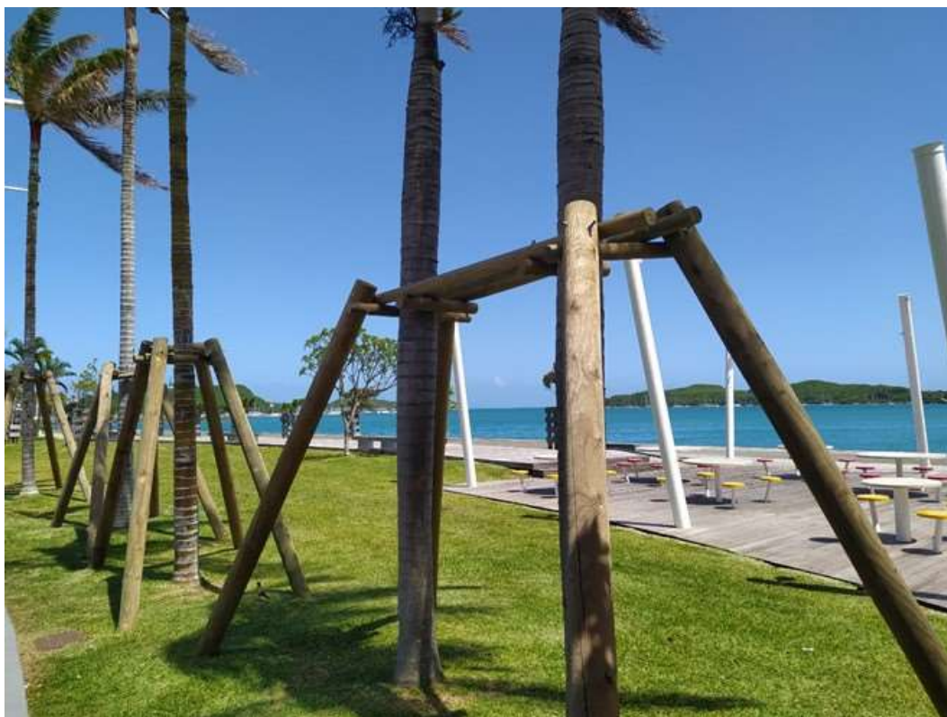
Photo 14. Eléments de structure pour tuteurage, pin des caraïbes traité CCA, Nouméa
