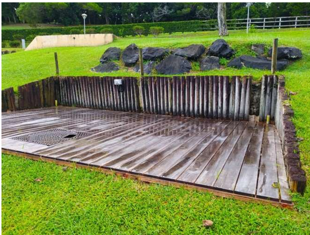
Photo 11. Mur de soutènement vertical, pin*, Nouméa
