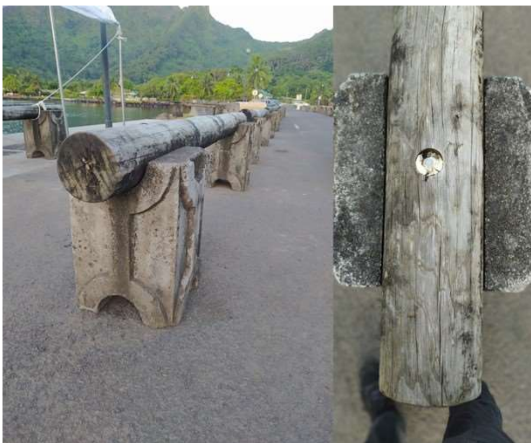
Photo 38. Bloc de sécurité en mixte bois-béton, pin*, Moorea
