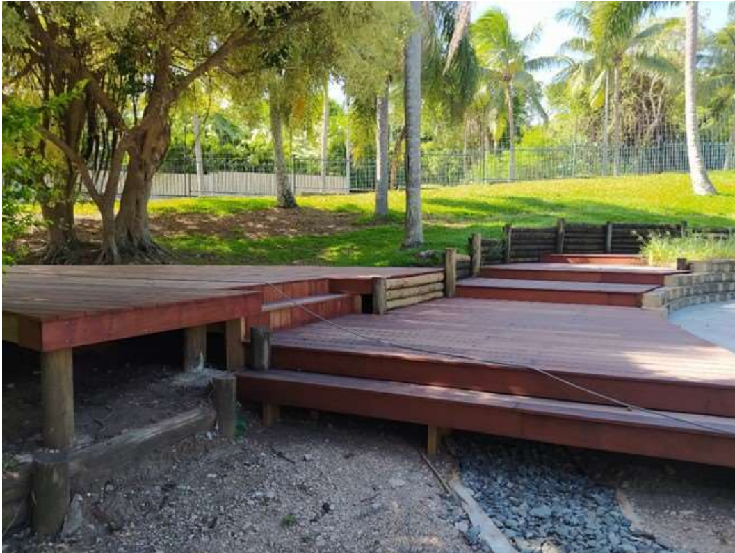
Photo 18. Platelage de terrasse en bois, pin*, Nouméa
