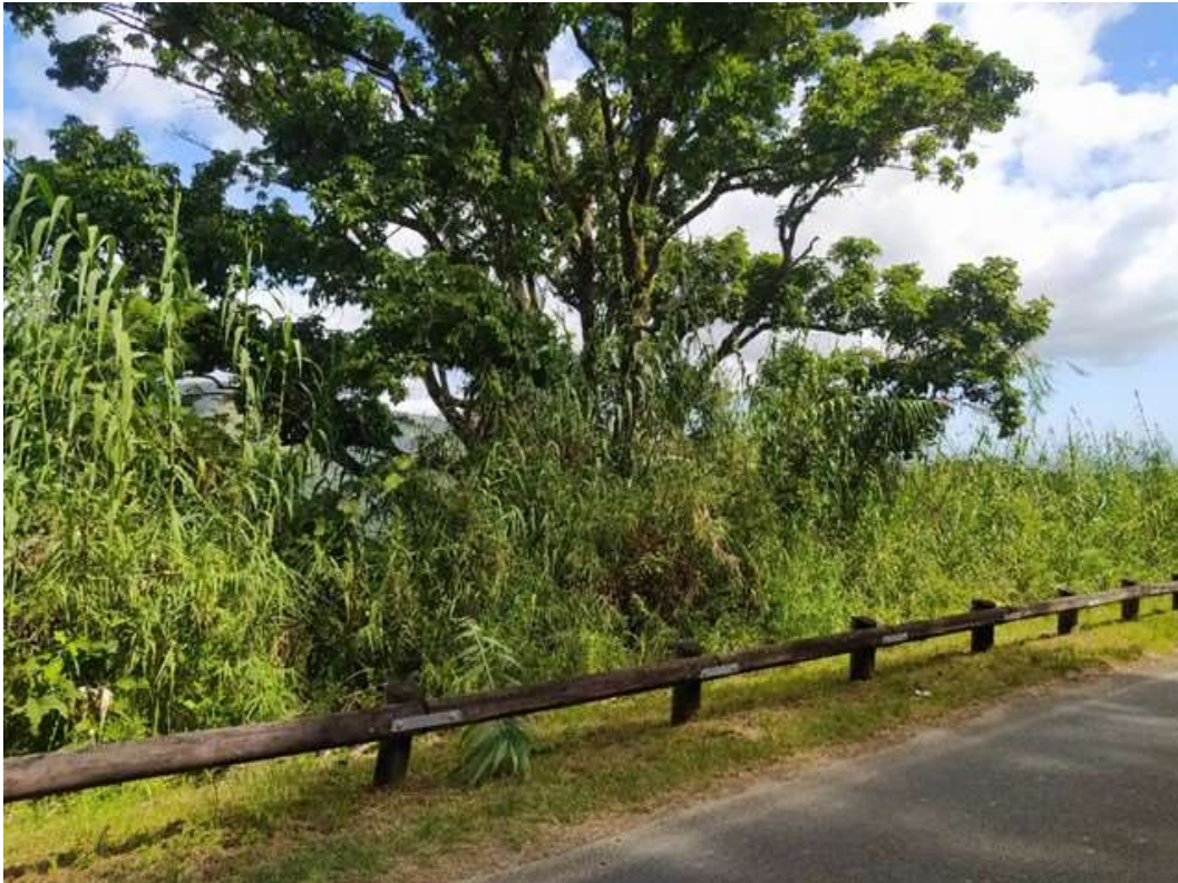
Photo 19. Glissière de sécurité en mixte bois-métal, pin*, Bouloupari
