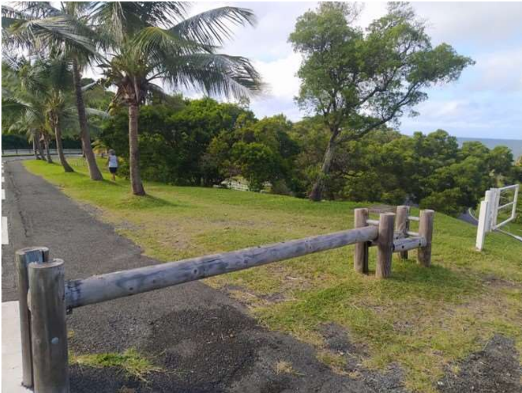
Photo 2. Structure pour éléments sportifs, pin radiata traité CCA, Nouméa
