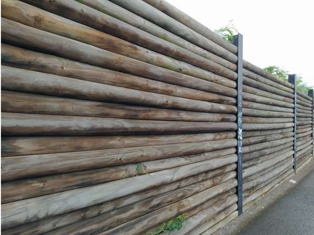
Photo 6. Mur de soutènement, pin*, Nouméa
