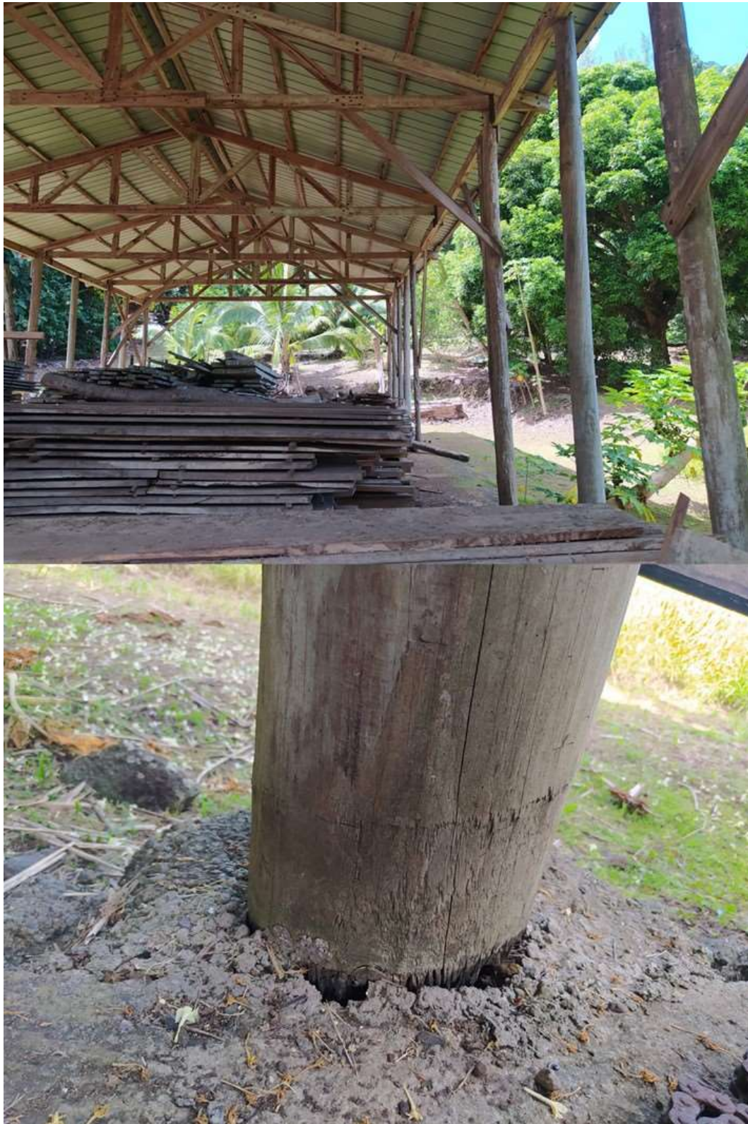
Photo 35. Structure porteuse en bois rond d'un bâtiment industriel, pin radiata traité CCA, Tahiti
