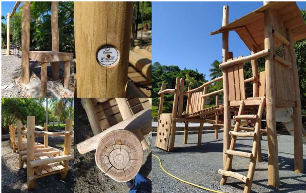
Photo 17. Structure d'air de jeux, robinier non traité (origine Pologne), Nouméa
