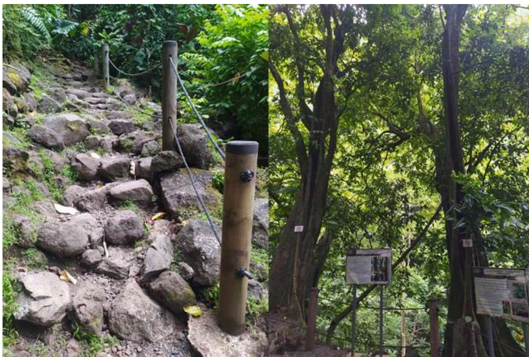
Photo 30. Barrières mixtes poteau-corde sur sentiers de randonnées, pin radiata traité CCA et peinture de couverture, Tahiti
