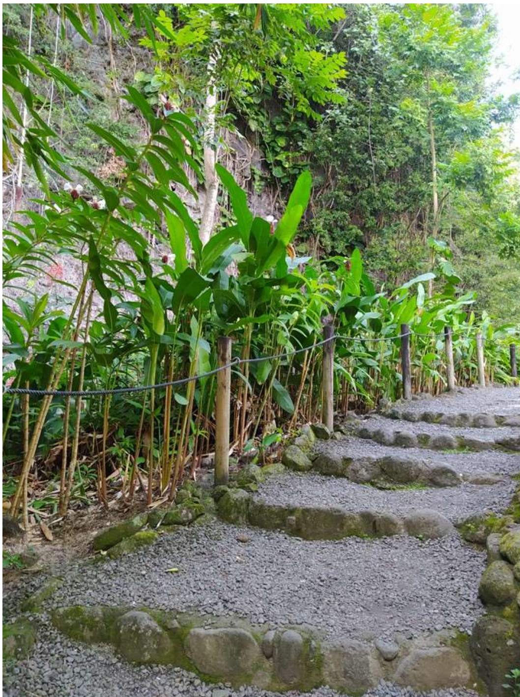
Photo 32. Barrières mixtes poteau-corde sur sentiers de randonnées, pin radiata traité CCA et peinture de couverture, Tahiti
