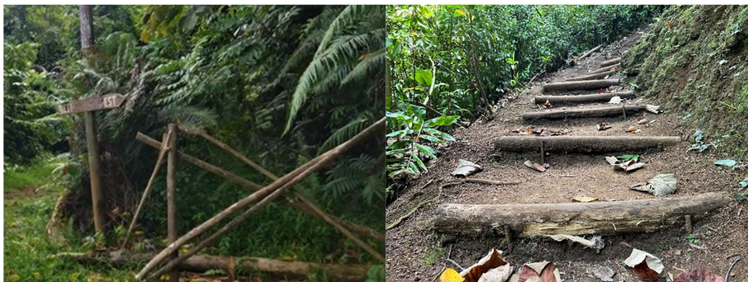
Photo 33. Poteau directionnel (bois rondinés) et retenues de marche (bois de récupération à proximité, pouvant être substitué par des bois rondinés) pour les sentiers de randonnées, Tahiti
