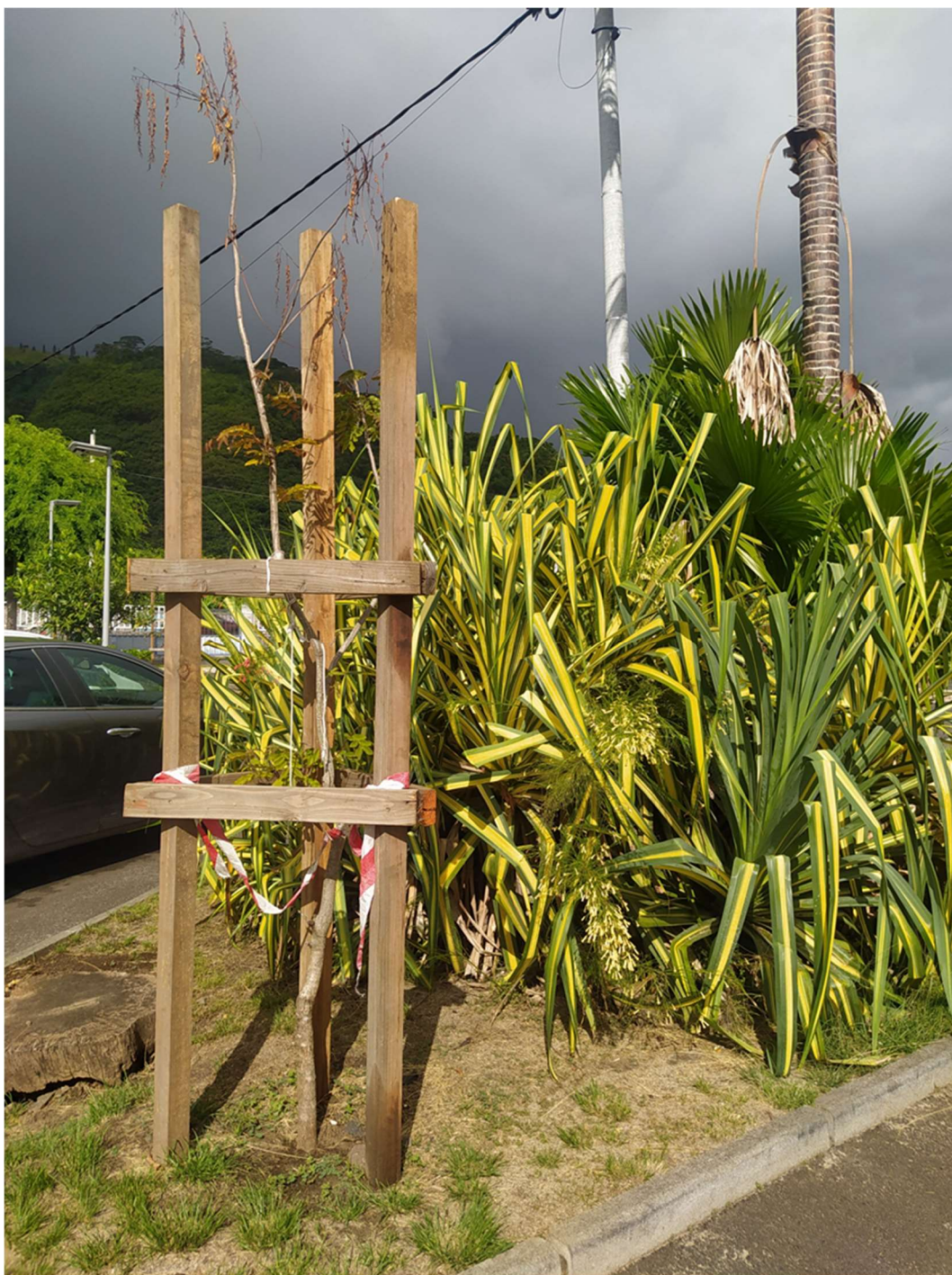
Photo 39. Tuteurage en avivés, pin* avivés (normalement prévus en bois ronds selon le CCTP), Moorea
