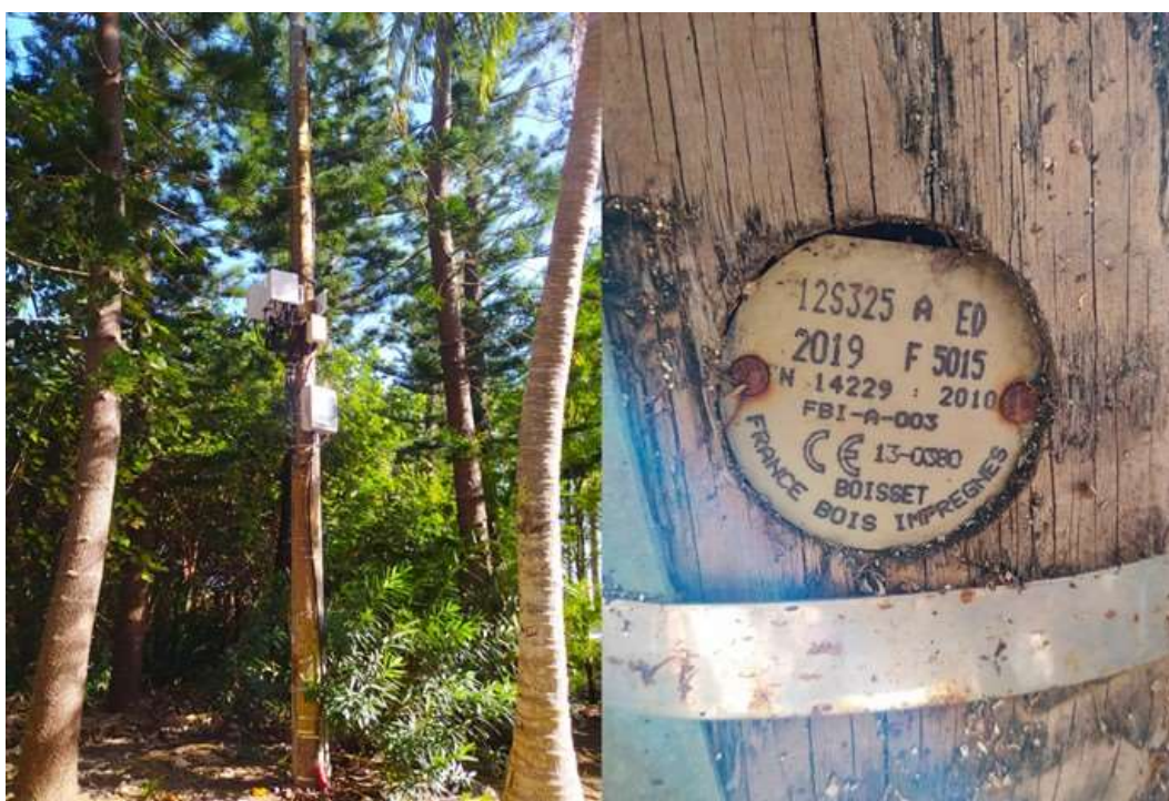
Photo 12. Poteau de ligne, pin sylvestre traité par injection en autoclave avec certification CTB P+, Nouméa
