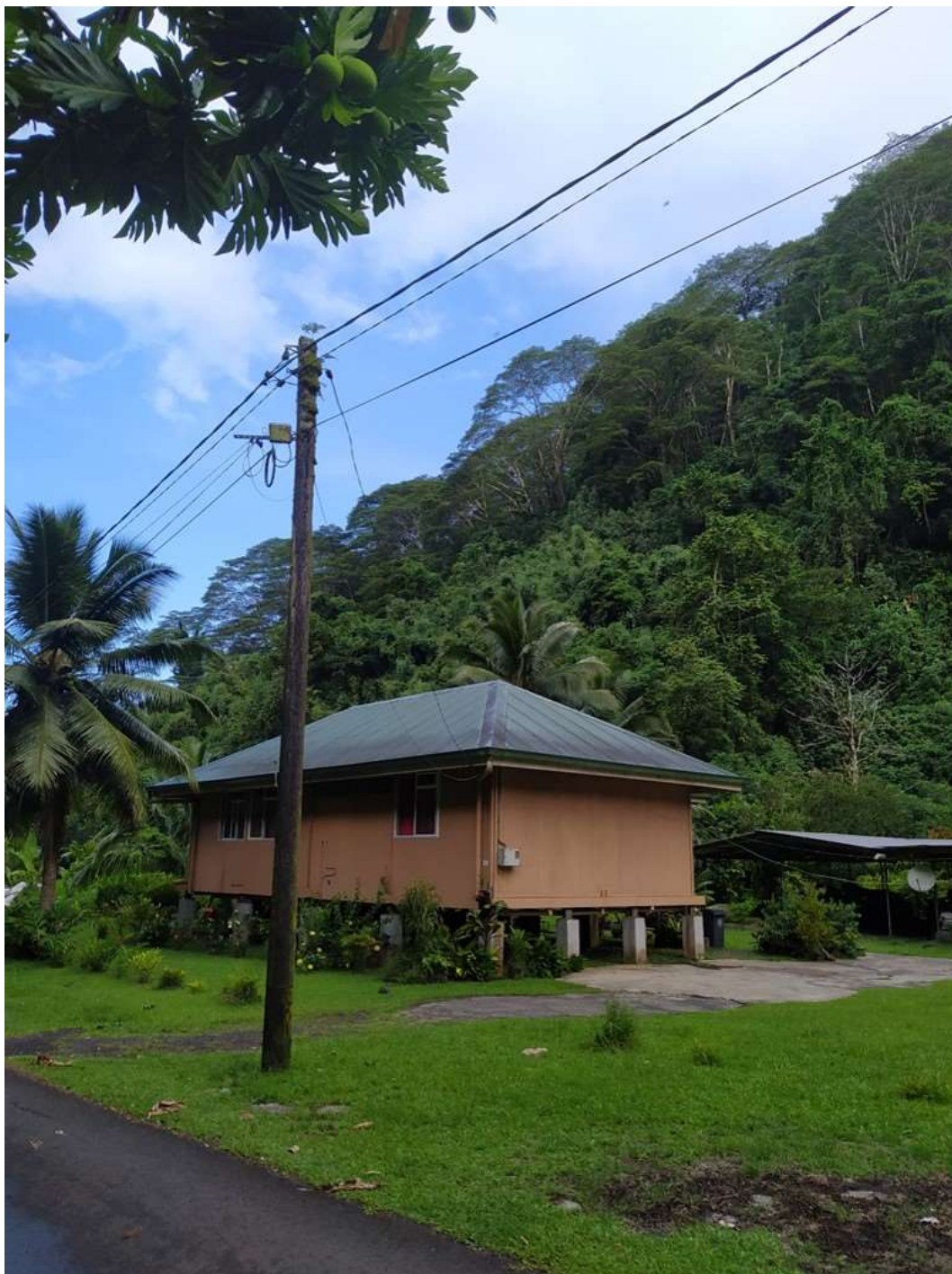
Photo 29. Poteau de ligne, pin hemlock traité au pentachlorophénol, Tahiti
