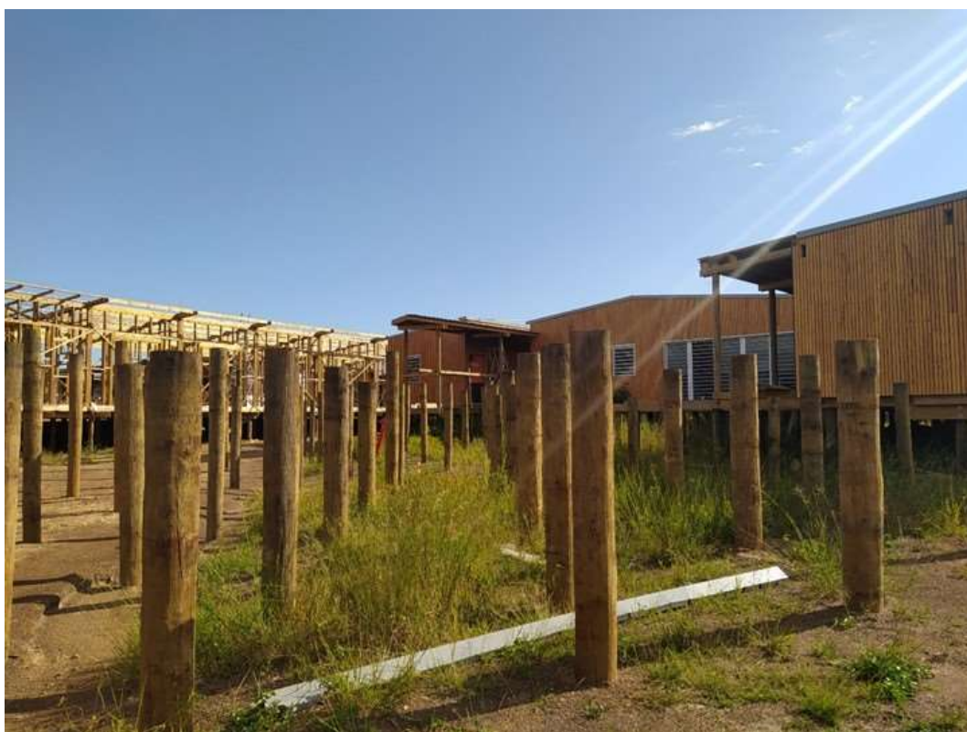
Photo 21. Chantier d'une maison médicale, structure bois (pin des caraïbes) sur pieux (pin radiata traité CCA), Bouloupari
