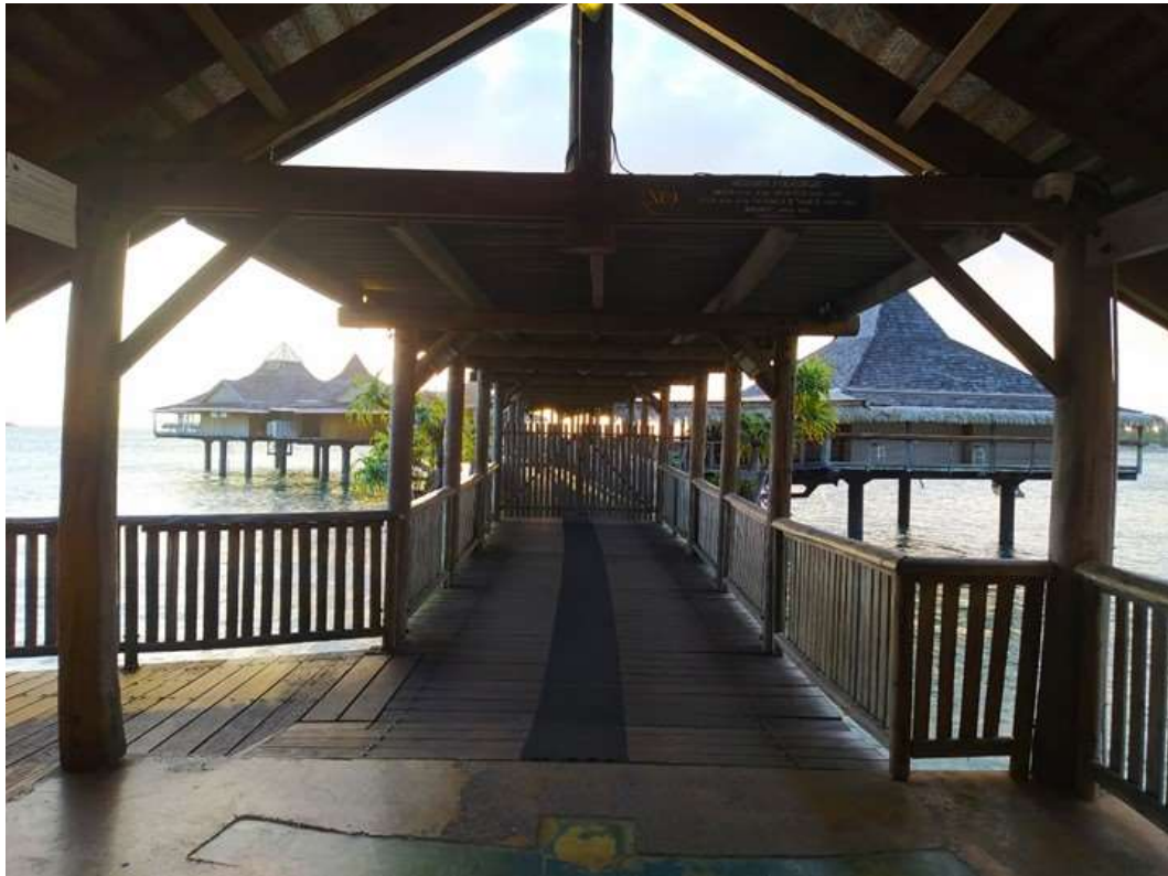
Photo 16. Structure de bâtiment touristique, pin*, Nouméa
