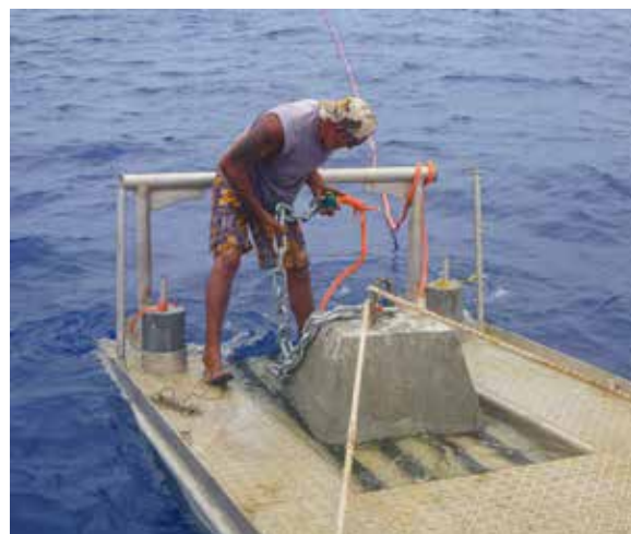
Photographie 10 : utilisation de la petite barge polynésienne pour la mise à l'eau du corps-mort.
