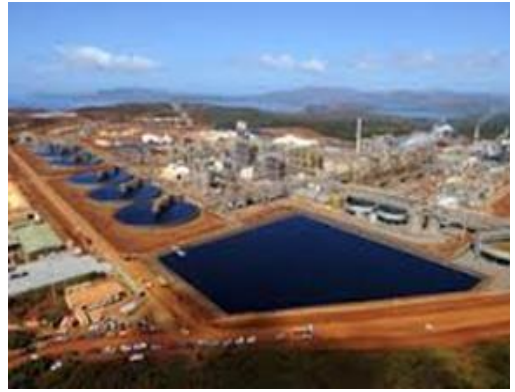
Figure 9 – Usine hydrométallurgique de Vale-NC (source : DIMENC)
