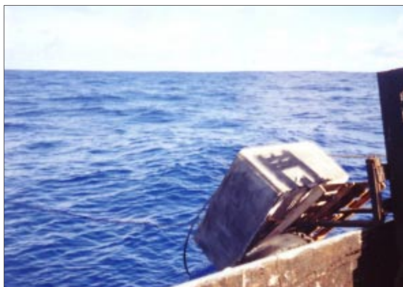
Figure 6: Mouillage du corps mort à l'aide d'un chariot élévateur à Aitutaki [Photo: Steve Beverly]
