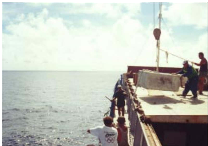
Figure 5: Mouillage du corps mort depuis le Manu Nui, à Rarotonga [Photo: Steve Beverly]
