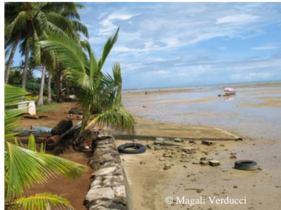
Photographie 12 : Littoral remblayé et enroché. Platier à marée basse
