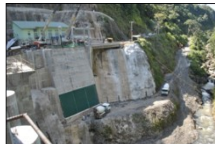
Construction du barrage Nadarivatu aux îles Fidji. Image © efl.com.fj
