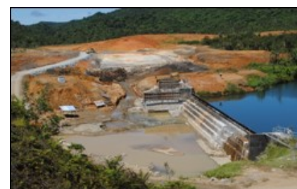
Construction du déversoir Wainisavulevu aux îles Fidji. Image © efl.com.fj
