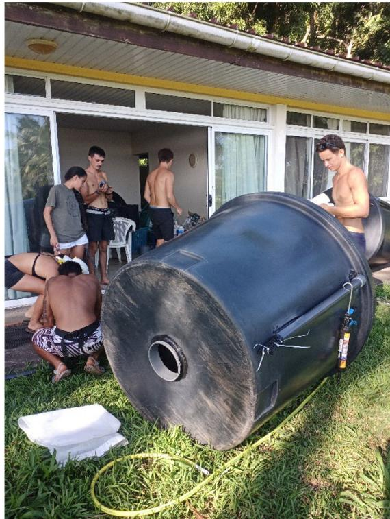
*Construction du prototype à partir d'une citerne de stockage des eaux pluviales d'1m<sup>3</sup>*
