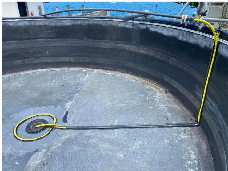
*Système d'aération dans un bassin de 15m<sup>3</sup> cylindrique*
