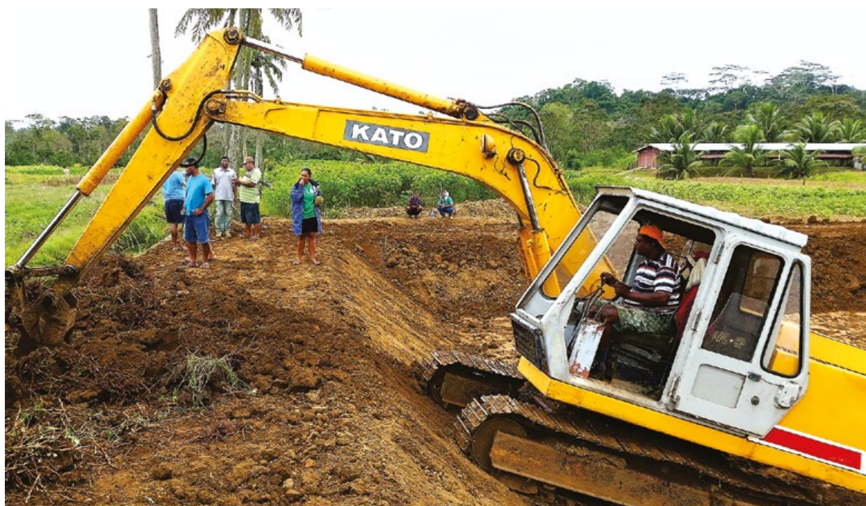
Les agents de vulgarisation ont également pu s'initier aux techniques de construction modernes en suivant les travaux de construction d'un bassin à l'aide d'un engin de terrassement (crédit photo: Tim Pickering).
