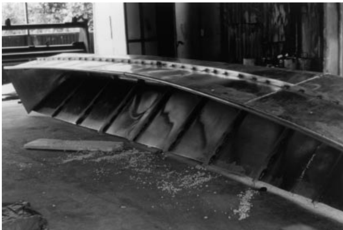
Figure 6 : Construction d'une coque de catamaran alia de 9 mètres.
