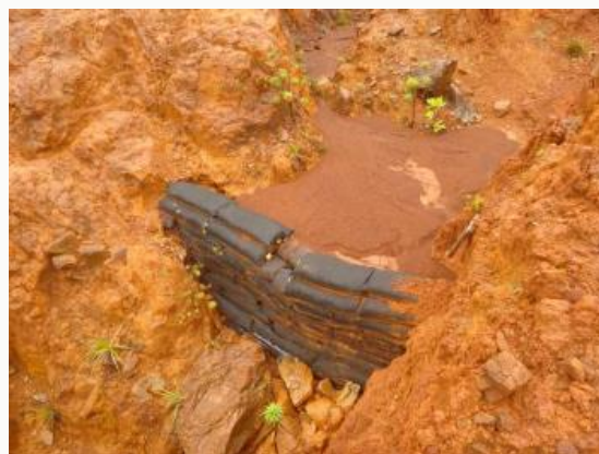
Seuil en Terralock (la coulée)
