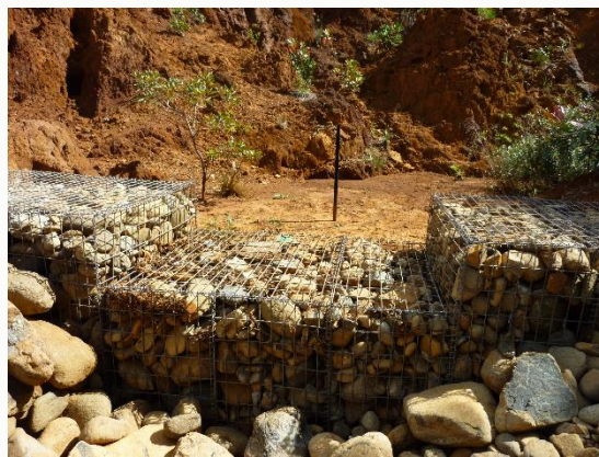
Seuil en gabions – La Coulée (Mont Dore)
