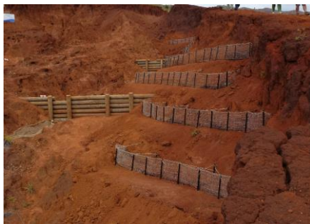
Figure 9. Banquettes grillagées en cours de construction
