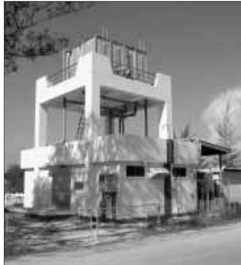
Figure 1. Nouvelle station de pompage d'eau de mer au SMC
