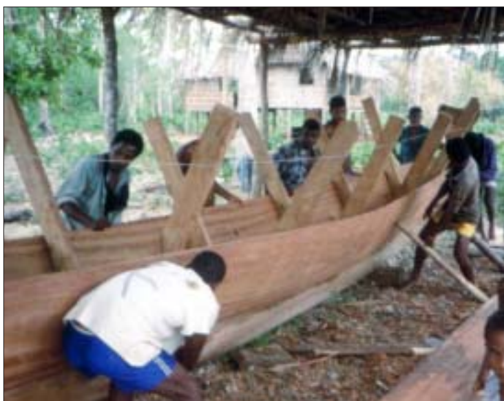
Figure 7. La quille avec les couples, et la mise en place du premier bordé. (M. Smaalders, 1997)
